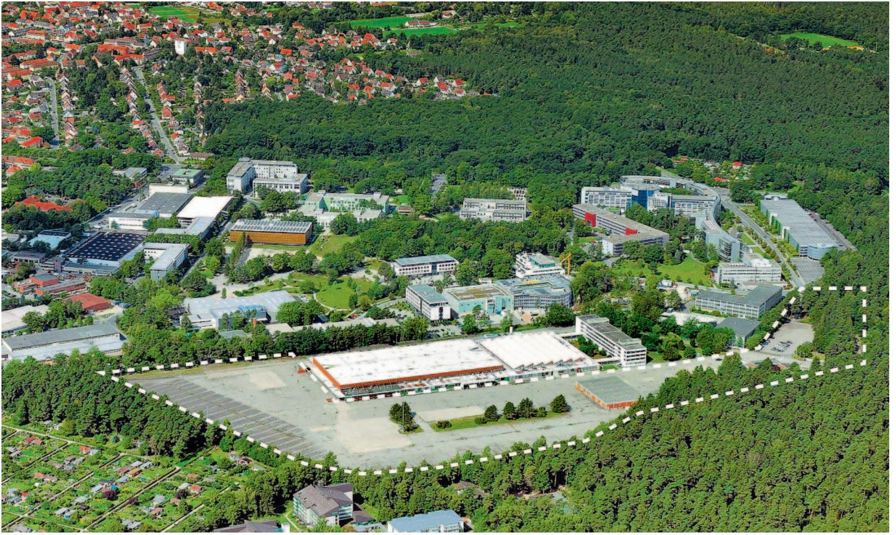
Rund 61 000 Quadratmeter groß ist das neu entstehende Gewerbegebiet im Norden Nürnbergs, das auf diesem Foto von gestrichelten weißen Linien begrenzt wird. Das Waldgebiet oben rechts grenzt direkt an den Flughafen an. Vor allem kleine und mittelständische Betriebe sollen im Norispark Platz finden. Luftbild: Werbeagentur Roth
